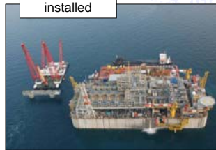
Adriatic LNG installed
