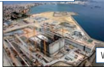
Construction of LNG terminal in Spain
